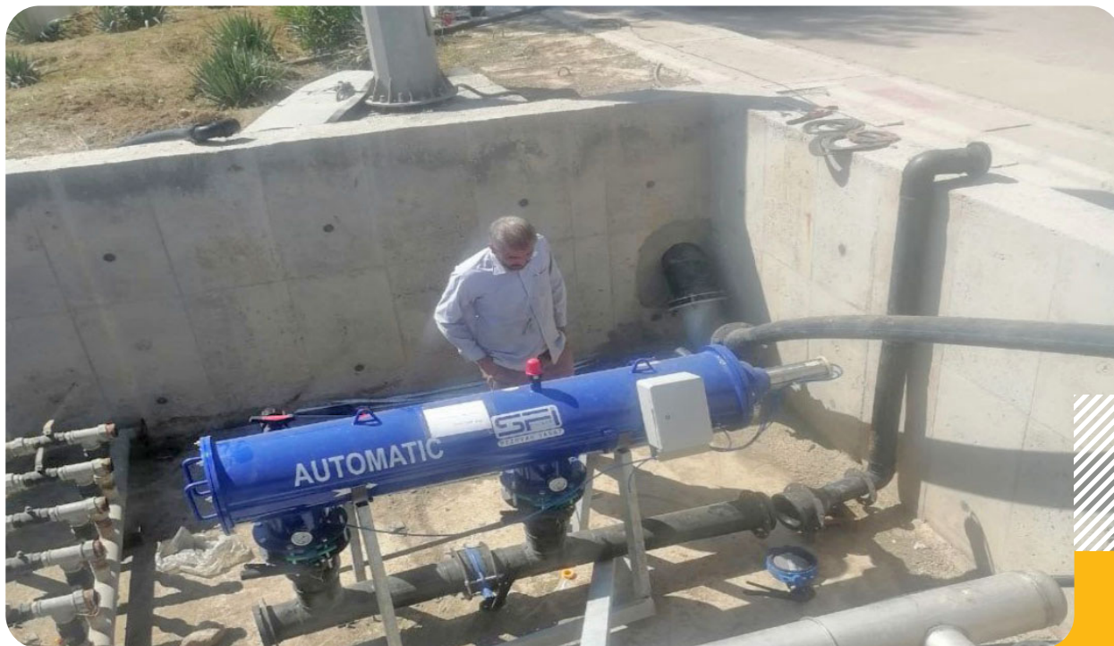
نصب دستگاه مدرن فیلتراسیون پساب خروجی جهت تأمین آب سرویس فرآیند
