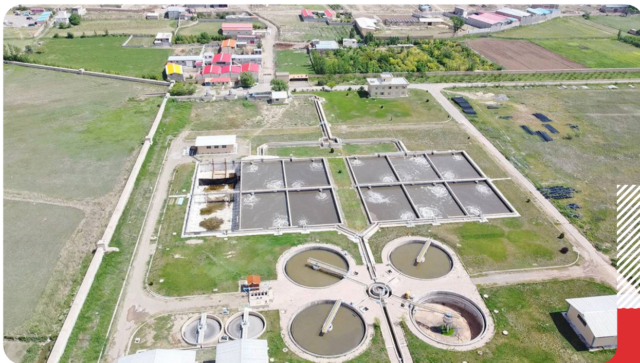
نمایی از تصفیه‌خانه فاضلاب شهر اهر با فرآیند تصفیه از نوع لجن فعال با هوادهی گسترده با نیتریفیکاسیون کامل
