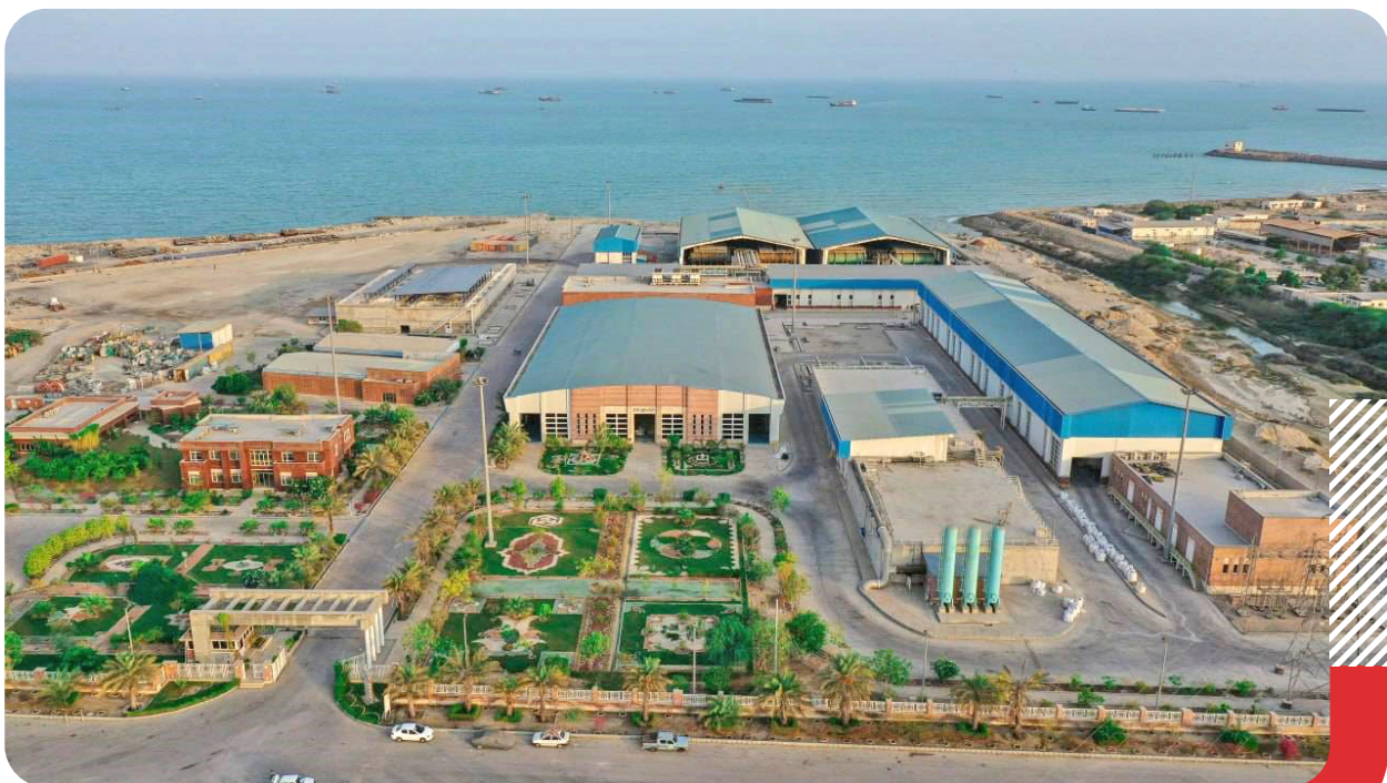
نمایی از تأسیسات آب شیرین کن یکصد هزار متر مکعبی شهر بندرعباس
