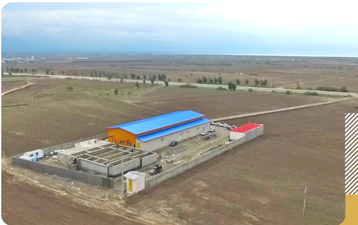
نمایی از تأسیسات آب شیرین کن شهرهای بندر ترکمن و گمیشان با تعداد ۲۱ حلقه چاهای محفوره برای تأمین آب لب شور طول خطوط انتقال آب خام حدودی ۲۰ کیلومتر و تعداد سه واحد RO با سیستم پیش تصفیه سافی کند و فیلتر سرامیکی
