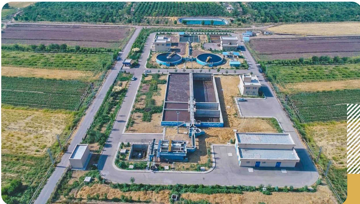
نمایی از تأسیسات تصفیه‌خانه فاضلاب شهر محمودآباد نمونه
