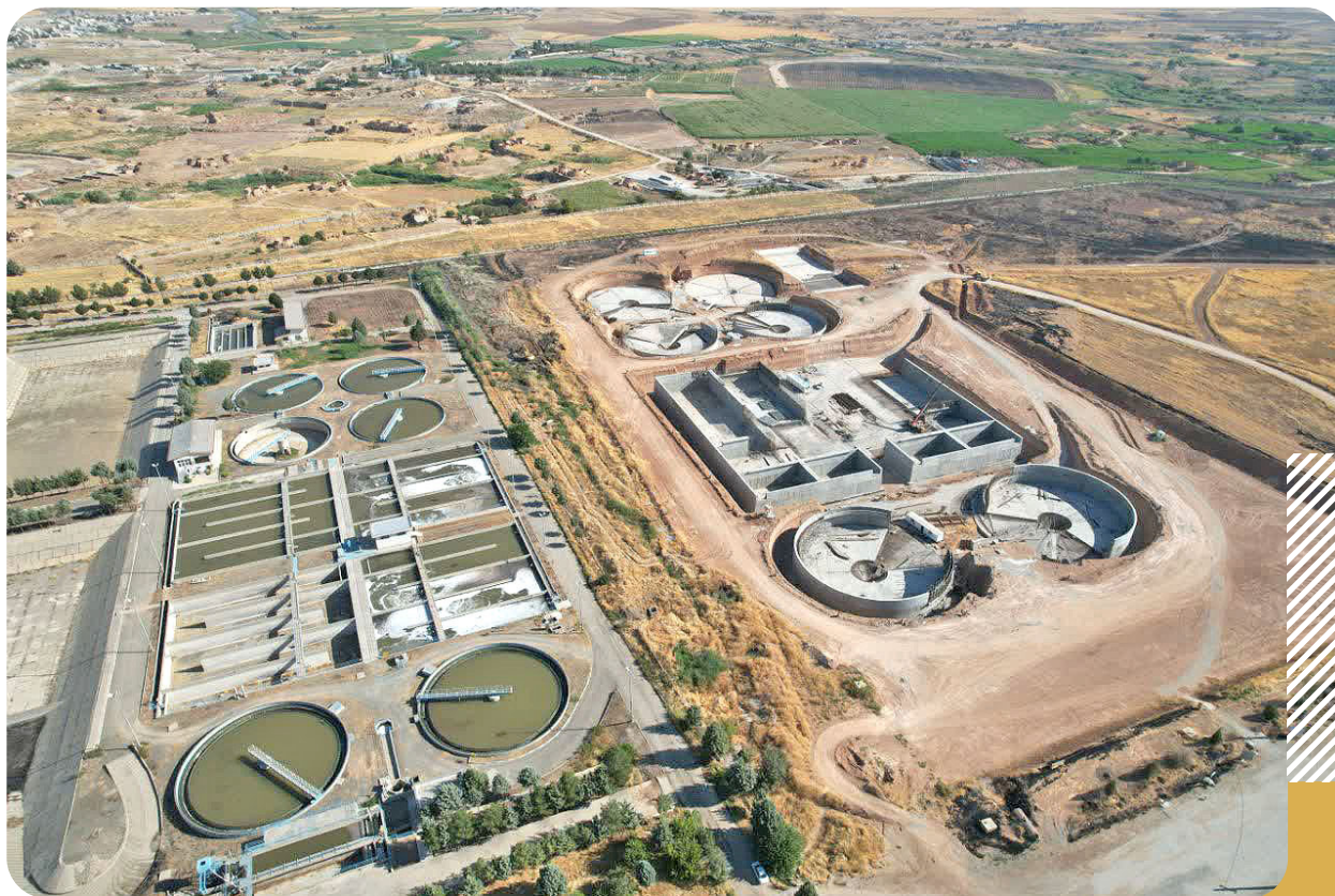
نمایی از تأسیسات تصفیه خانه فاضلاب شهر کرمانشاه
